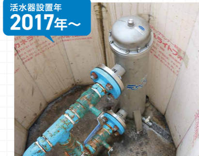
業務用FFC元始活水器V40型を設置しています。 ※凍結防止のため、地中に埋設。
