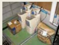
原水が硬水のため、塩を少量加え、機械で軟水化します。これ以外にも塩を加えることにより、菌のコントロールをしたり、FFC処理水との相性が良く効果をより引き出すなどの目的があるとのこと。
