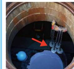
FFCセラミックシステムを8kg設置されています。
